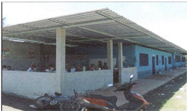
Foto 3: Estructura de pórtante de metal, lamina y mejoramiento de un aula
