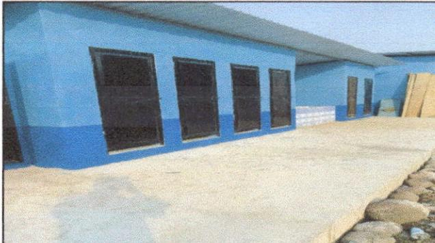
Foto 2: sustitucion de puertas de metal en servicios sanitarios, cambio de lamina por lamina traquelada calibre 26
