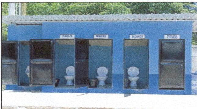
Foto 5: sustitución de puertas de metal, piso de concreto
