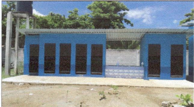
Foto 1: sustitucion de puertas de metal en servicios sanitarios, cambio de lamina por lamina traquelada calibre 26
